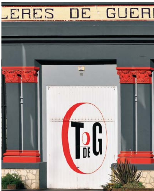
3. pabiloiko fatxadaren xehetasuna. (Santi Yaniz) Detalle de la fachada del pabellón n.º 3. (Santi Yaniz)
