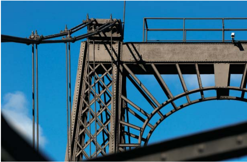
Kableen euskarriaren xehetasuna zutabeetako batean, eta penduluen euskarriari dagokiona. (Santi Yaniz)
