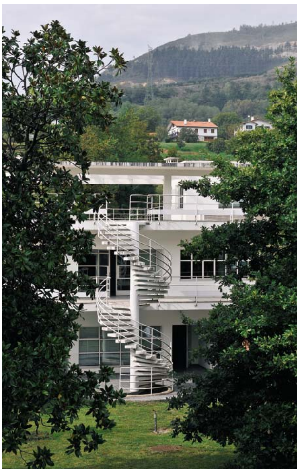
Jantoki-eraikineko eskaileraren xehetasuna. (Santi Yaniz) Detalle de la escalera del edificio de Comedores. (Santi Yaniz)
