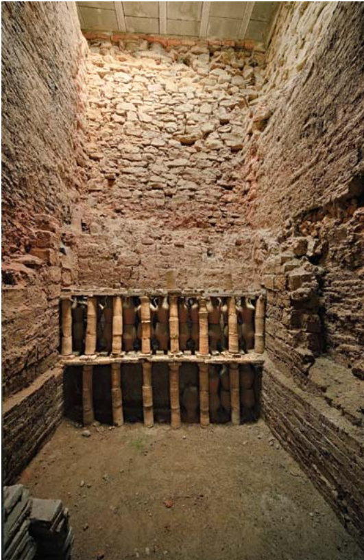
Goranzko aireztapena edo tiro bertikaleko antzinako zeramika labearen barnealdearen xehetasuna. (Santi Yaniz)
