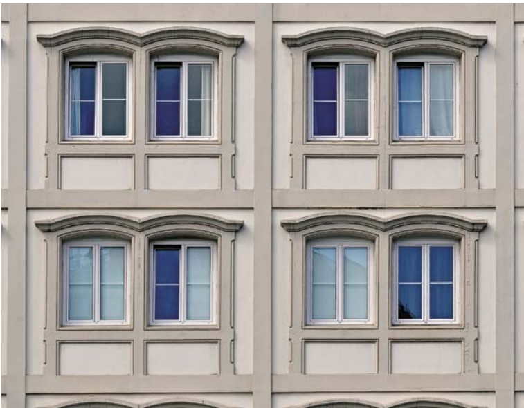
Aurre fabrikaturiko harri artifizialezko pieza modularren bidez eraikitako fatxadaren xehetasuna. (Santi Yaniz) Detalle de la fachada construida mediante piezas modulares prefabricadas de piedra artificial. (Santi Yaniz)
