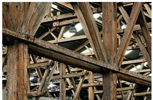
Zertxei eusten dien txarrantxaren xehetasuna. (Santi Yaniz) Detalle del arriostamiento que soporta las cerchas. (Santi Yaniz)
