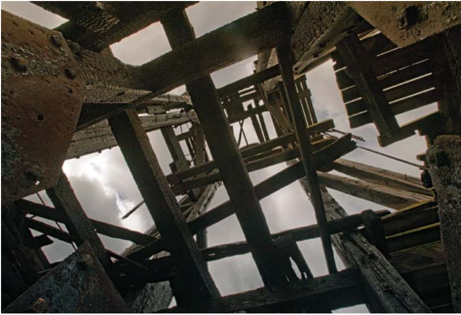
Txarrantxa bertikalen eta horizontalen xehetasuna. (Santi Yaniz)
