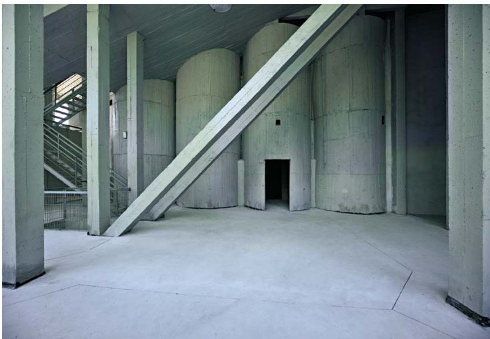
Hormigoi armatuz egindako biltegi-siloak birgaitze lanen ondoren. Sekzio zirkularrekoak eta 12 m garai ziren, eta bakoitzak 80 tonako edukiera zuen. (Santi Yaniz)
