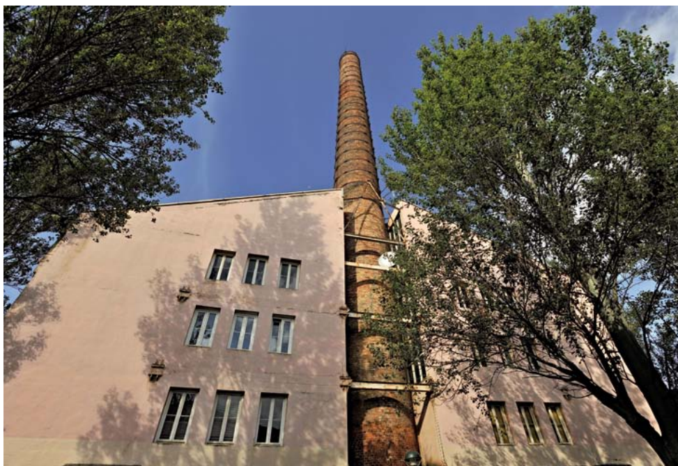
50 m-ko garaierako tximinia, eraikinean enbutitua. (Santi Yaniz) Chimenea de 50 m de altura, embutida en el edificio. (Santi Yaniz)
