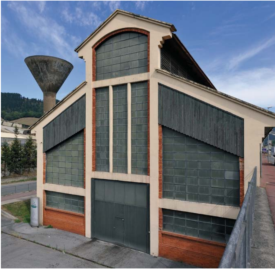
Xafla-ijeztaketako nabearen hegoko fatxada, 1926. (Santi Yaniz) Fachada sur de la nave de laminado de chapa, 1926. (Santi Yaniz)
