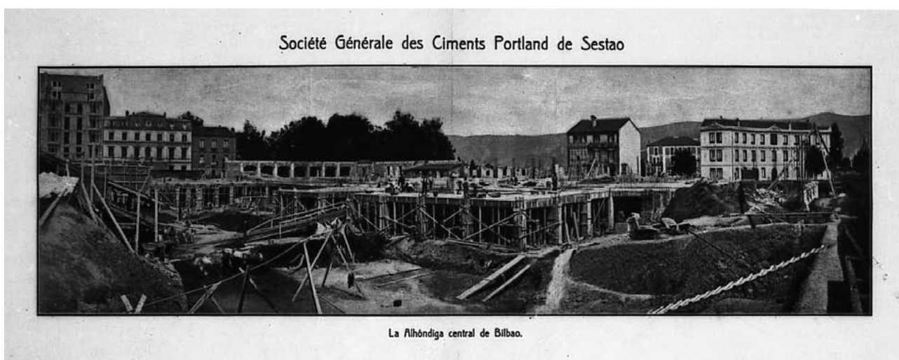
Alondegia obretan. Argazkian, sotoaren egituraren lanak aurreratuak eta beheko solairuaren aurrealdeko ekialdea hasieran. ( Hormigoi armatua , 1907. Joaquín Carcamoaren biduma)
